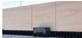
①大引き受け部材を設置
