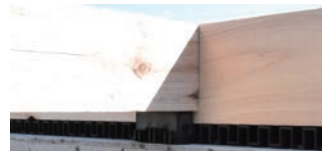
②大引き受け部材の上に大引きを設置
