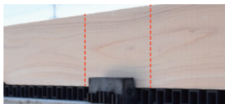
①大引き受け部材を設置
