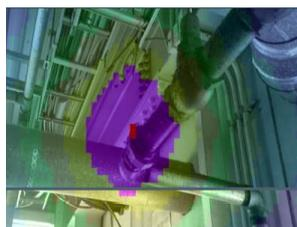
保温材による冷却水槽の放熱ロス低減
