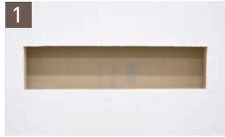
1 内側に下地材を組み、壁材に140×576mmの開口部を開けます。
