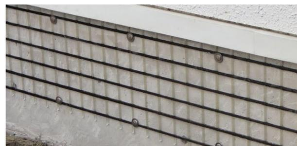
FRPグリッドは、炭素繊維、ガラス繊維などの高性能連続繊維を、耐食性に優れたビニルエステル樹脂に含浸・硬化させ、格子状に一体成型したFRP(繊維強化プラスチック)製の格子筋です。
