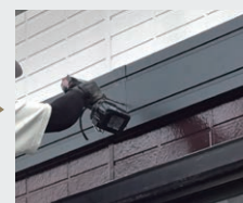
3 幕板カバーの取り付け 納まり図をご確認ください。
