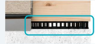
清掃方法としては、農業用噴霧器や水道ホースで床下空間の内側から換気スリット部分に水を噴霧し、泥を排出します。水圧の強い高圧洗浄機は、狭い床下空間での取り扱いが難しく危険を伴うためおすすめしません。床下空間からキソパッキングの換気スリットを見て、屋外の明るさが確認できるようになれば、換気スリット内部の泥などが排出されたと判断できます。
