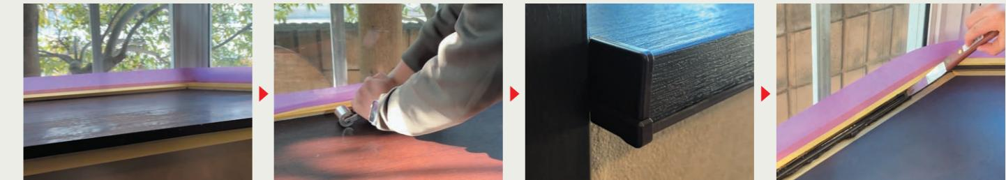
5 サッシ、壁、チリ部カバー材の折り返し部を養生。
