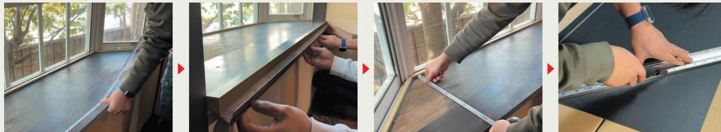
1 既存枠チリ部の長さ、見付け寸法を採寸し、チリ部カバー材をカット。
