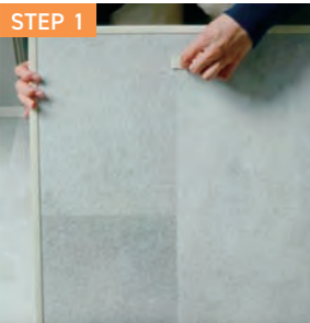
既存点検口のフタを取り外す
